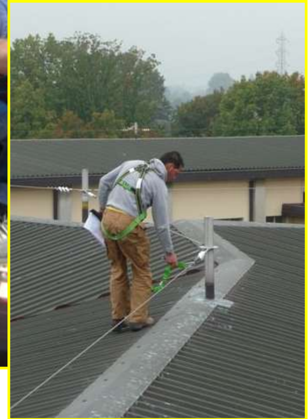
Verifica ancoraggi per linea vita in classe C
