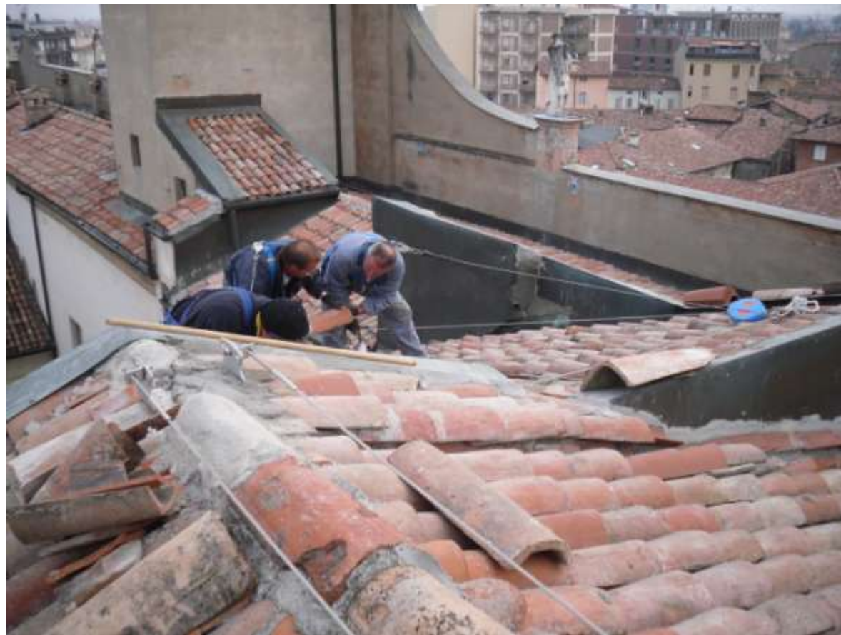
Delle lavorazioni da eseguire in copertura
